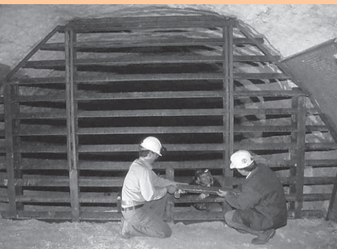
Препоръчителен дизайн на решетка при наличие на прилепна колония в изоставена мина (Илинойс, САЩ)
