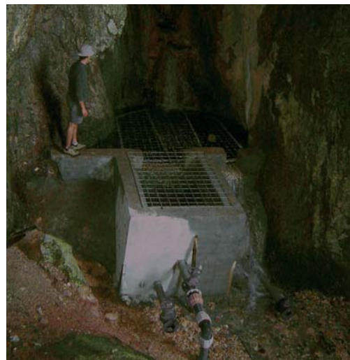
Каптажно съоръжение на Входа на пещерата „Гаргина дупка“, с. Мостово, Западни Родопи
