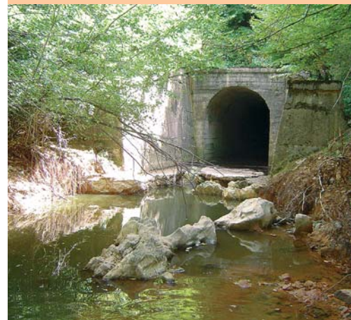
Тунели и канали за деривация
