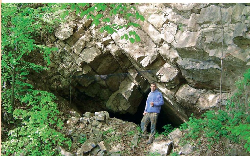
Входът на изоставената минна галерия под връх Издремец над с. Лакатник е застрашен от срутване поради естествена ерозия на склона. В тази галерия са установени 15 вида прилепи. (НАТУРА зона: Искърски пролом – Ржана – BG0001042)
