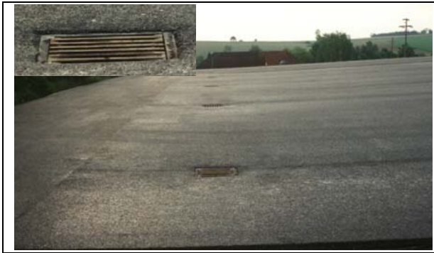
Фигура 17: Наклон на площадка за компостиране с непропусклива повърхност
