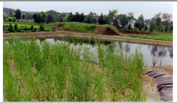
Фигура 18: Биологично пречистване на отпадъчните води, басейн за съхранение на водите
