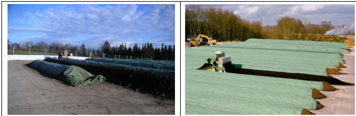
Фигура 12: Два примера за типични непроницаеми площадки за компостиране на открито с едностранен наклон 3 - 5 % (редовете са покрити с геотекстилно покритие)
